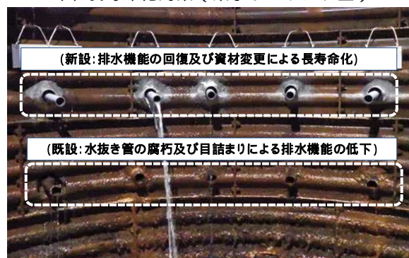
<図>長寿命化対策（集水ポーリング工）
